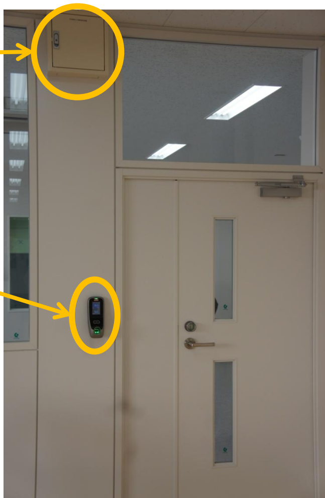
電気錠制御盤
